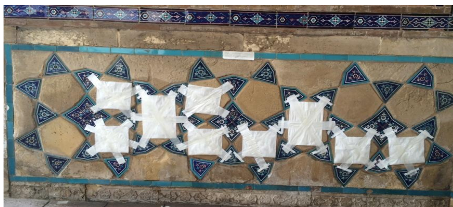
Сурет 2 – Тұзды қатпарларды компресс әдісімен жою
