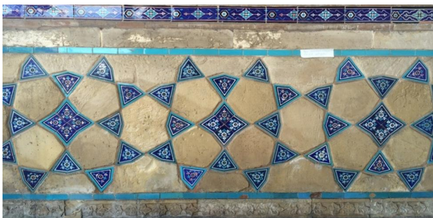
Сурет 3 – Компресс әдісінен кейінгі тұздардан тазарған кесене бөліктері
