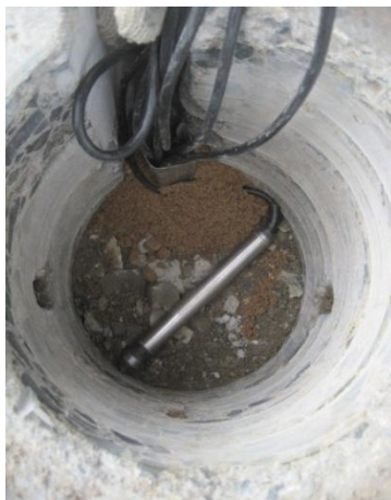
Рисунок 10. Закладка датчика в дорожную конструкцию
