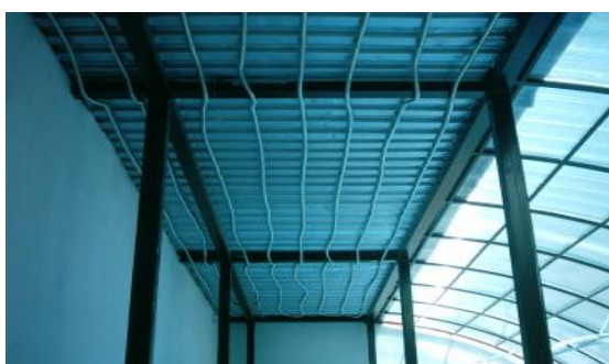
Рисунок 5 - Потолочный теплообменник рекуперации тепла.
